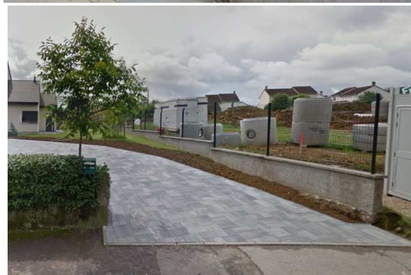
Clôture muret surmontée d'un grillage
