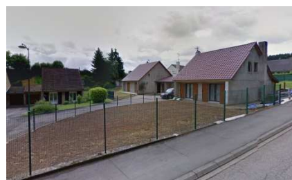
Clôture en grillage
